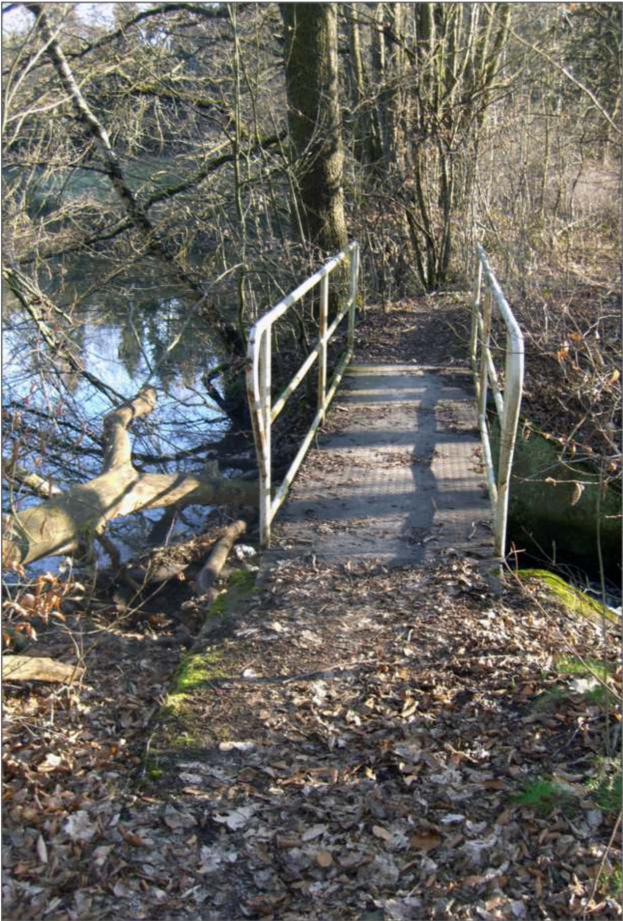
Brücke zur Schaltisinsel
