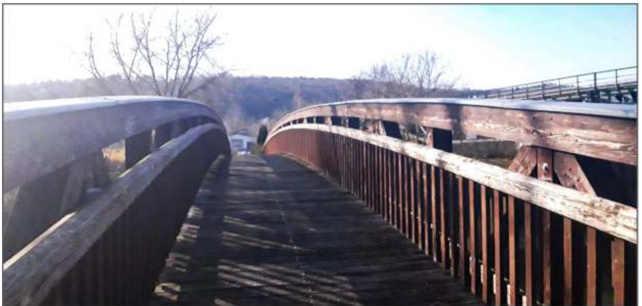
Elsterbrücke in Greiz
