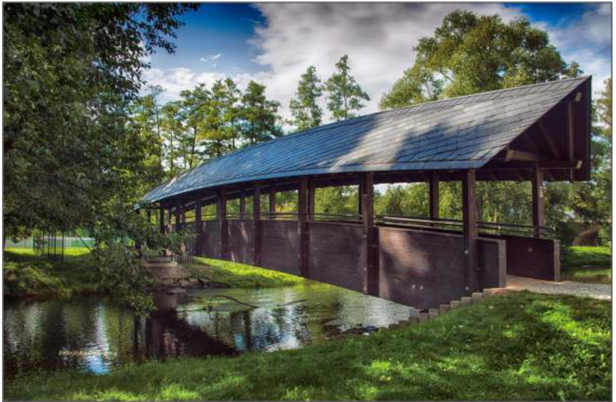
Fußgängerbrücke über die Elster bei Weischlitz
