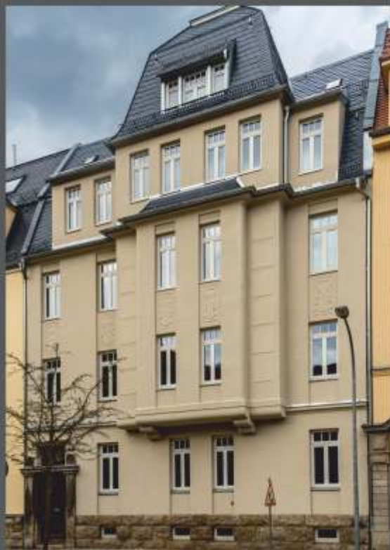
Andreas Schöpe - Prof.-Dr.-E.-Schneider Straße 4 - Baugeb. 1910/11 Mit Formen des Jugendstils gestaltete Fassade
