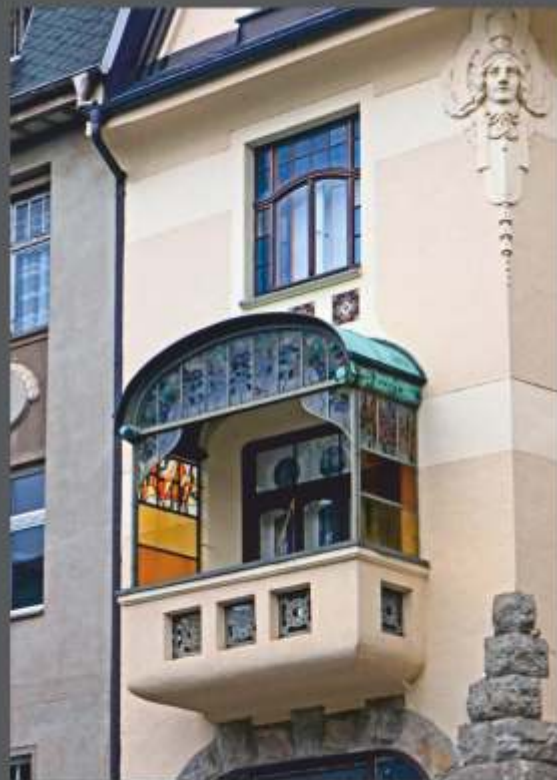
Elke Feyand - Burgstraße 8 - Baujahr 1909 Erker und Balkone beleben das Gesamtbild in alle Richtungen.
