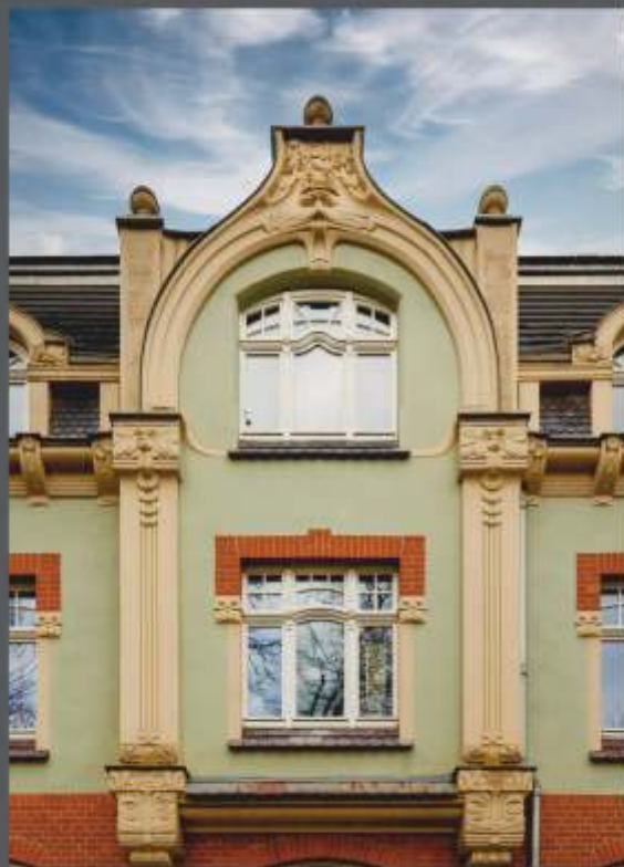
Ernst Müller - Parkhaus 107/108 - Bauges. 1900 Erker mit Maske in der Giebelkranzung
